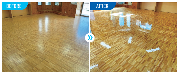
幼保連携型認定こども園 三葉幼稚園様 工法：下処理研磨+UV コーティング（無垢床 集成材）
