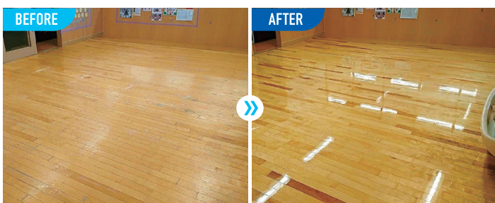
菩提寺優愛保育園モンチ 工法：下処理研磨+UVコーティング（無垢床）
