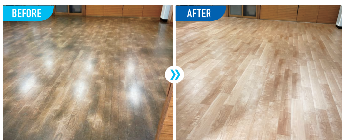
宗教法人 日本基督教団 錦林教会 日本ベスタロッツ保育園 工法：上張り+UVコーティング（フローリング）
